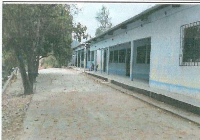
Foto 1: Área donde se contempla construir la estructura de techo de lámina, espacio que será utilizado para poder realizar reuniones con padres de familia y realizar diferentes actividades educativas
